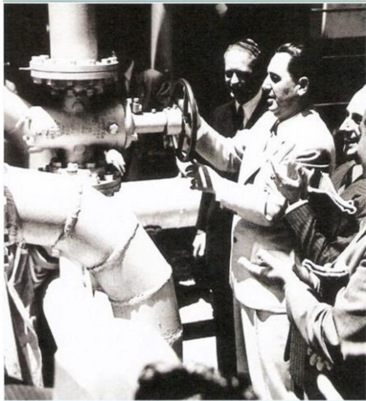
El Gran Gasoducto
